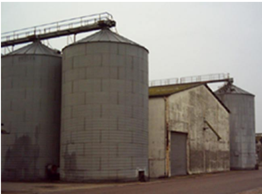
LES SILOS, distribution en INTERNE équipés d'une vis sans fin à tenir la malléabilité, brassage continu.
