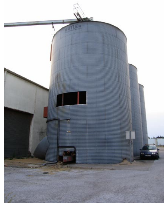
LES SILOS, distribution en INTERNE équipés d'une vis sans fin à tenir la malléabilité, brassage continu.
