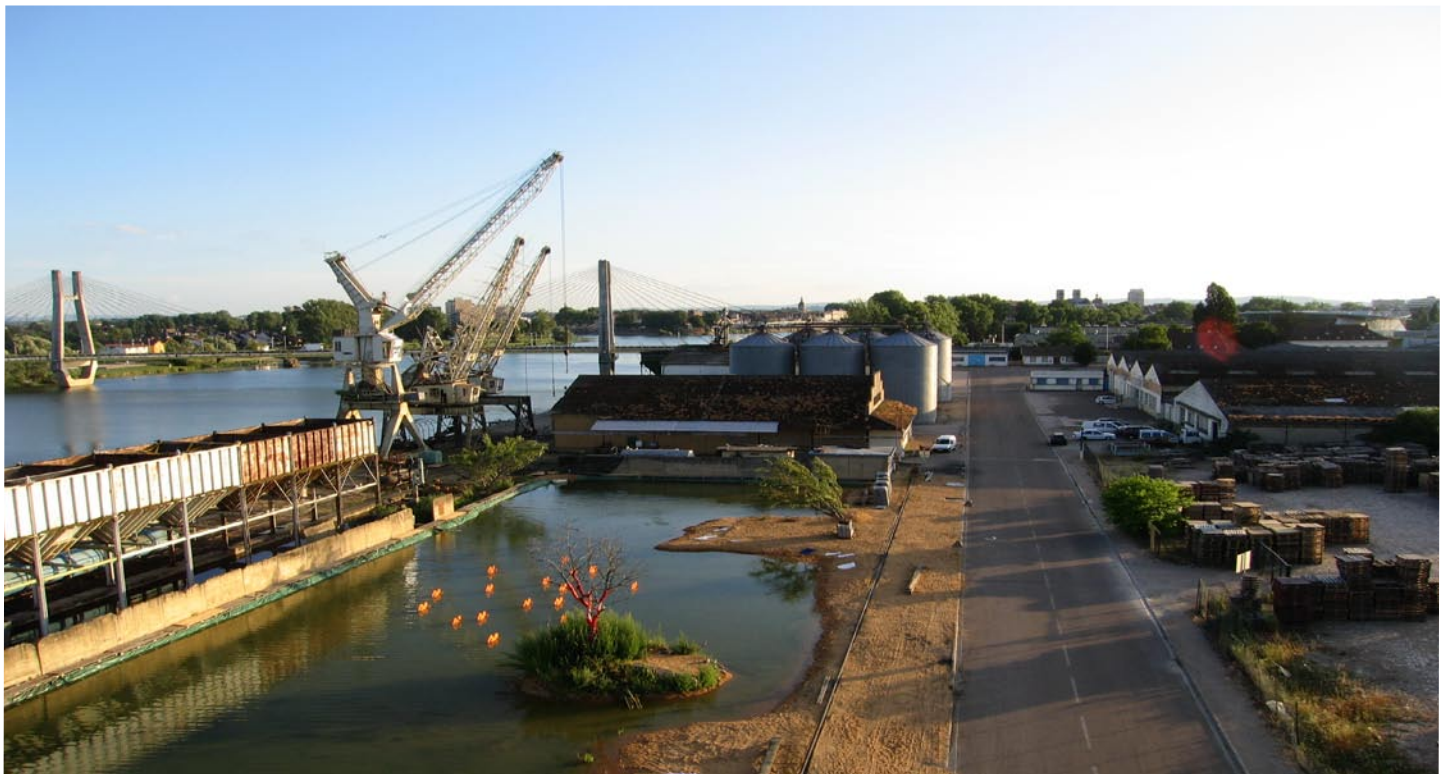
Sur le portique , le point de vue roulant en déplacement
